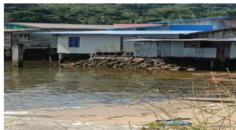
Menambag Batu Laut Dijadikan Pondasi Pembangunan
